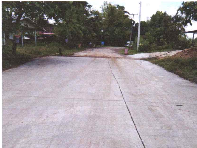
ภาพดำเนินการแล้วเสร็จ
